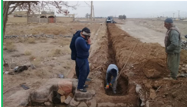
آران و بیدگل- آغاز عملیات لوله گذاری مزرعه صدر نوش آباد
