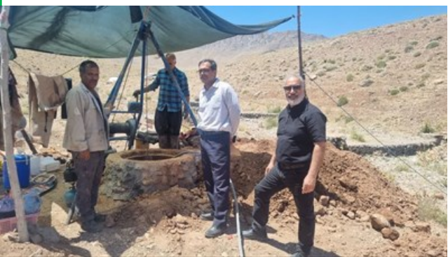
لنجان - بازدید نظارتی معاون آب و خاک سازمان از پروژه‌های زیربنایی
