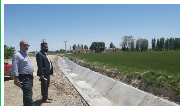
گلپایگان-بازدید از مراحل اجرایی پروژه احداث کانال اورانجوبه
